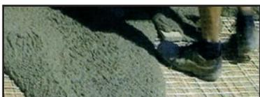
**Voce di Capitolato** - Caldana in calcestruzzo armato composta da conglomerato cementizio dosato a q.li 3,00 del cemento tipo 325, per uno spessore di cm 4. E' compresa l'armatura con rete in fibra di vetro con trattamento ANTIALCALINO tipo **TEX 40-40**. Posta in opera sulle falde del tetto a protezione dell'isolamento termico e/o dell'impermeabilizzazione. E' inoltre compreso quanto altro occorre per dare l'opera finita.
