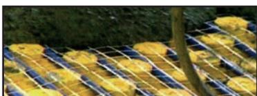
**Voce di Capitolato** - Massetto autolivellante composto da inerti selezionati e additivi fluidificanti a base cementizia o base gesso, armato da una rete in fibra di vetro RESISTENTE ALL'ALCALINITA' DEL CEMENTO e RESISTENTE ALL'ANIDRIDE PRESENTE NEL GESSO tipo **TEX 40-40**. Dato in opera rifinito, è inoltre compreso quanto altro occorre per dare l'opera finita.
